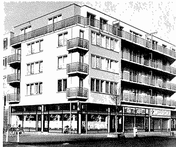
Woningen aan de Von Zesenstraat/ Dapperstraat, hoek noordzijde
